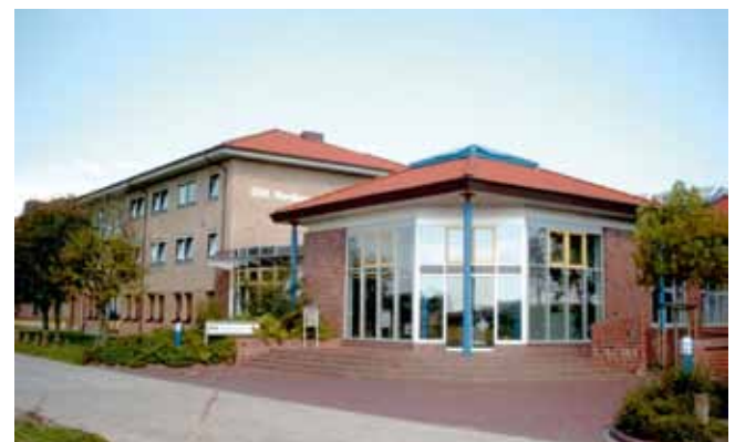
DRK-Nordsee-Kurzentrums Friesland in Schillig
