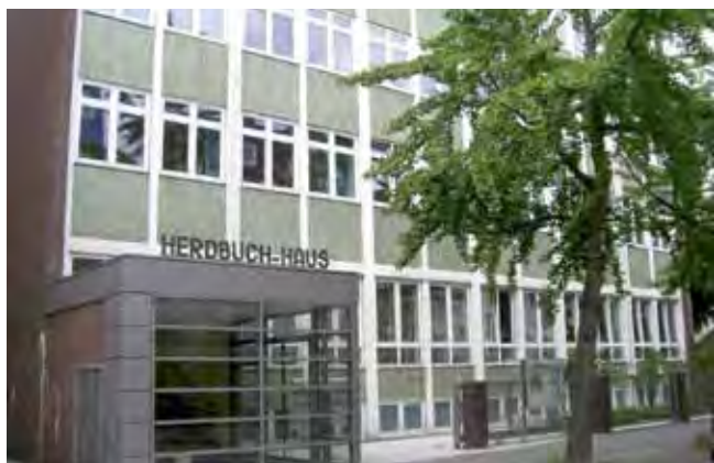
Die DRK-Landesgeschäftsstelle in der Kaiserstr. Oldenburg bis Mitte Februar 2014
